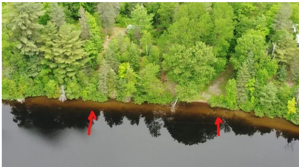
Figure 16. Érosion de l'avant berge
