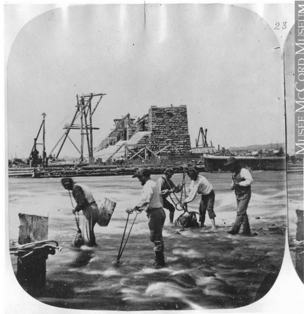
Des ouvriers qui travaillent à la construction du Pont Victoria en 1859.
